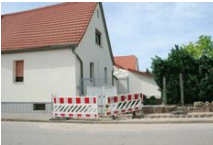
Tiefbauarbeiten am Verteilerkasten(Ibersheim)
