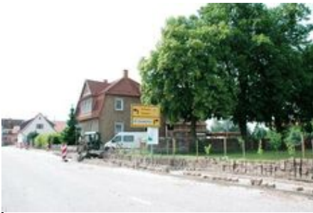
Baustelle in Ibersheim
